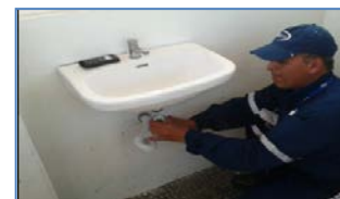
Mantenimiento de Instalaciones Sanitarias en Garitas de Vigilancia.
