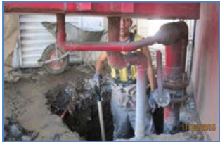
Filtración en PEAS por rotura en ducto producto de mala manipulación de retroexcavadora – Trabajos
