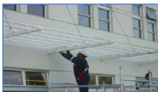
Mantenimiento de pinturas exteriores.
